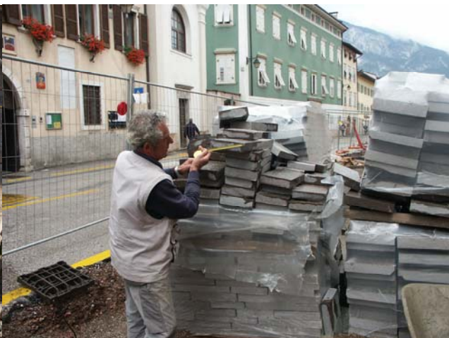
Verifica del materiale
