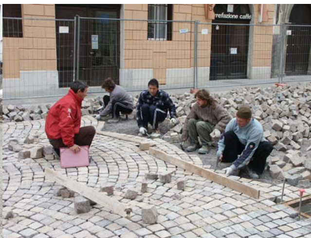
Monitoraggio della fase di posa
